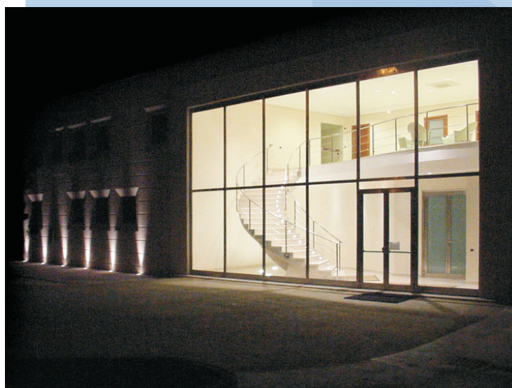
Entrata Stabilimento di Salerno
